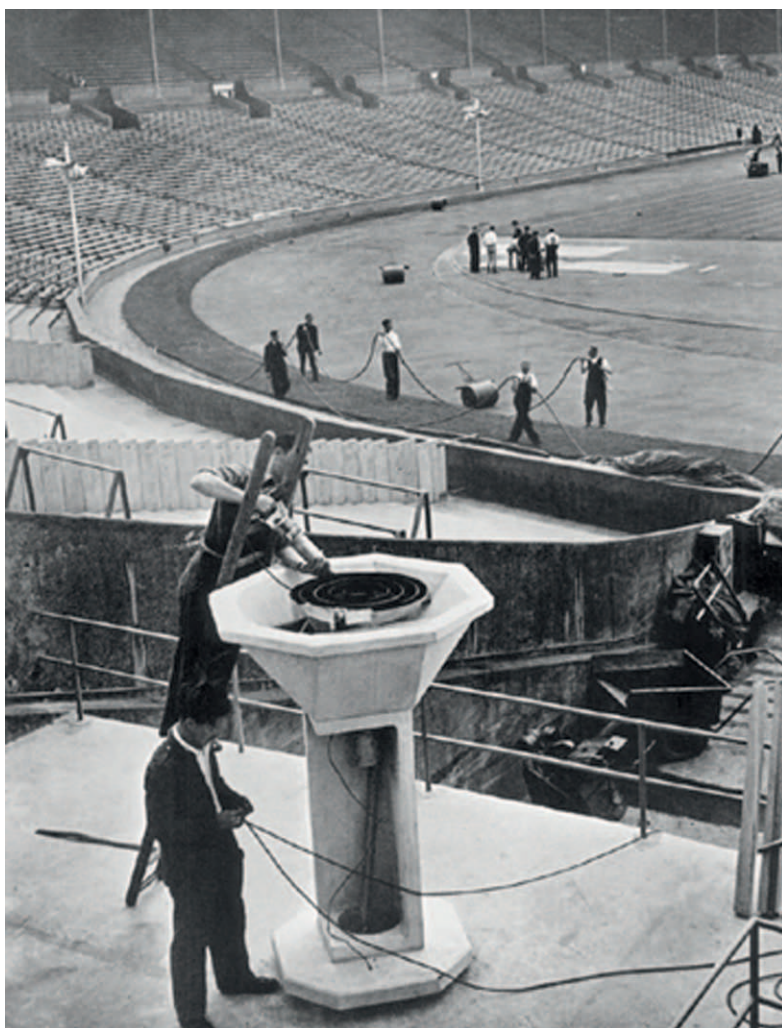
Instandsetzung des Wembley-Stadions. Bis wenige Wochen vor der Eröffnungsfeier in London am 29. Juli 1948 wurden hier noch Hunderennen veranstaltet. Quelle: Offizieller Bericht, S. 52
