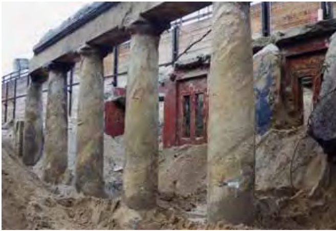
5. Freilegung der Säulenarkade, Aufnahme: Peter Lemburg 2001
