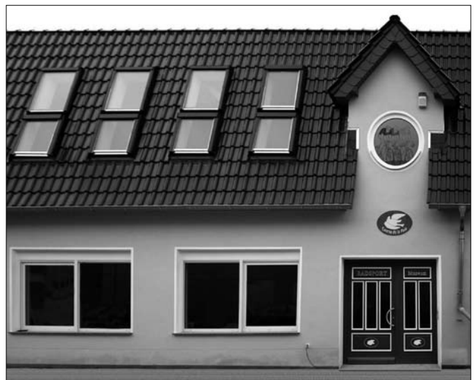
Vom baufälligen Haus zum Friedensfahrt-Museum
